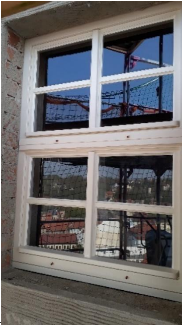
Neues Fenster in Türmerstube
